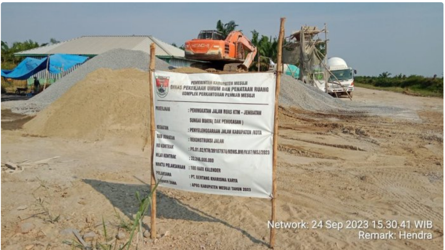
Pekerjaan rigit beton pada ruas penangkis Sungai Buaya Mesuji
