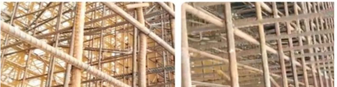
Proyek Jembatan Gantung
